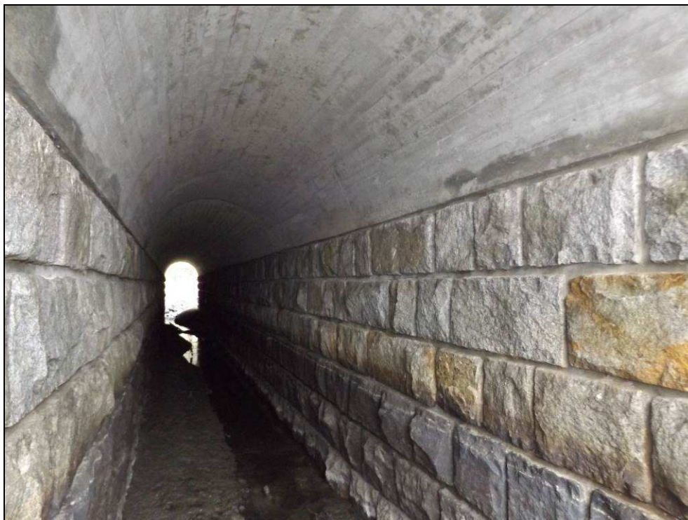
Obr. č. 6 - pohled na NK a SS vybrané opěry objektu. Spodní část fotografie zachycuje zanešené koryto náplavami.
